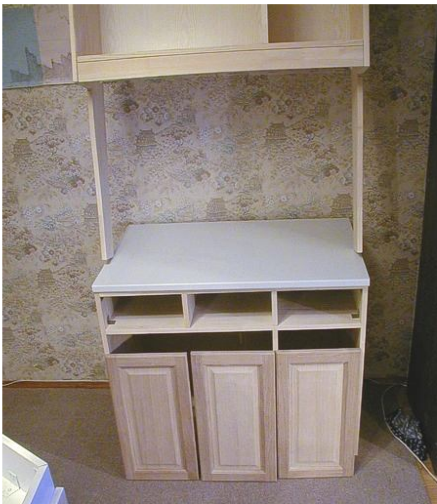
А сверху уже - заготовка для настенного шкафа
